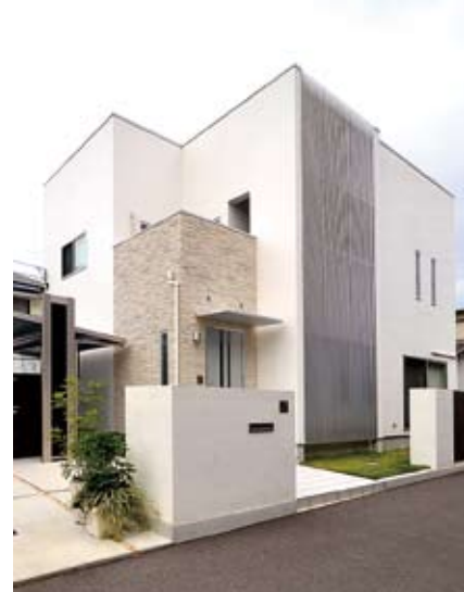
白を基調としたシンプルモダンな外観。縦スリットの格子が外壁のアクセントに。
