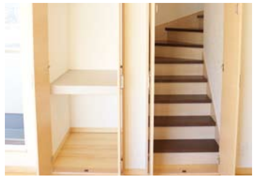
収納に見える扉を開くと、小屋裏へ続く階段が隠れている。
