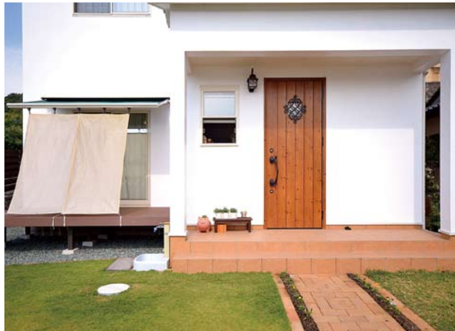
芝生のグリーンと調和するレンガ素材を使った玄関ポーチ。白壁に映えるアンティークをイメージさせた木目調の扉もポイント。
